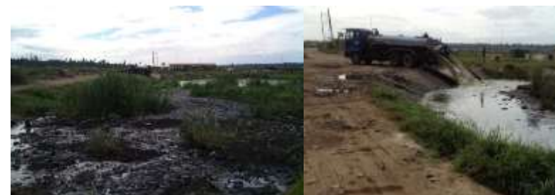
Vista de descarga de lamas na ETAR
